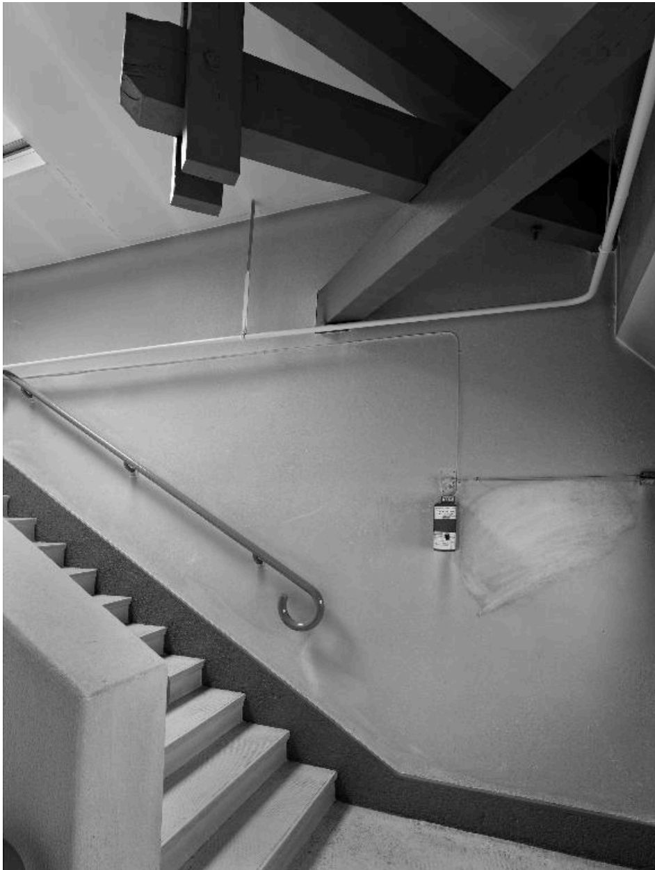
Bâtiment rue Duhamel : dernière volée de l'escalier nord et détail de la charpente bois du pavillon
