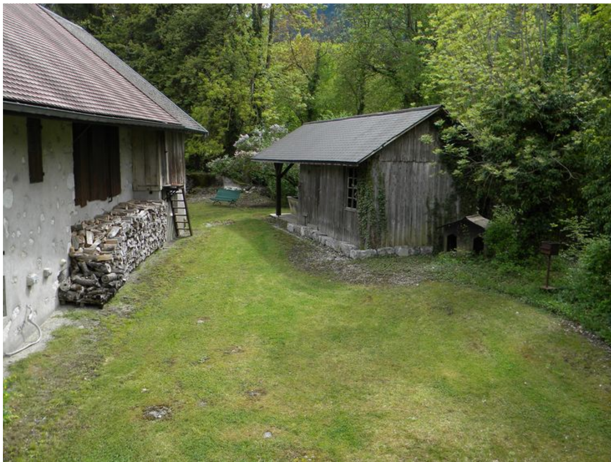
Détail de la façade arrière avec le hangar abritant un bassin privé.
