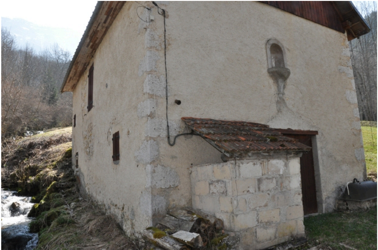
Vue des façades ouest et nord
