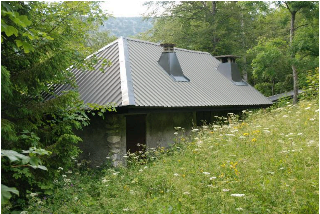
Vue d'un chalet (2016 G2 402) aux Chalets Ballan (non repéré).
