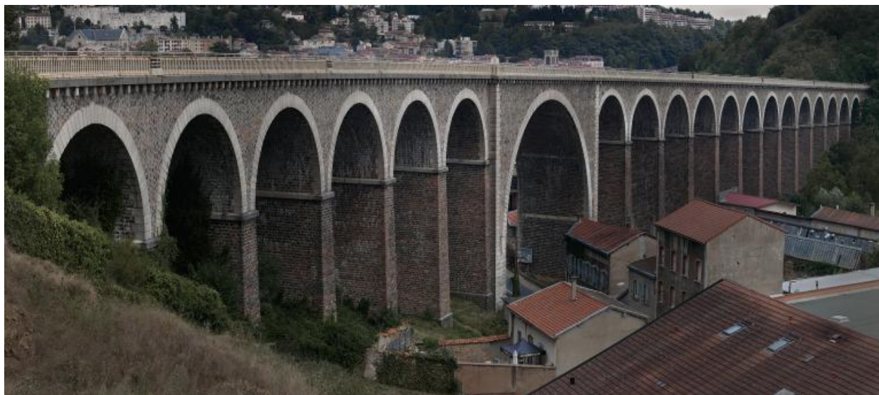
Vue d'ensemble du viaduc de Tarare
