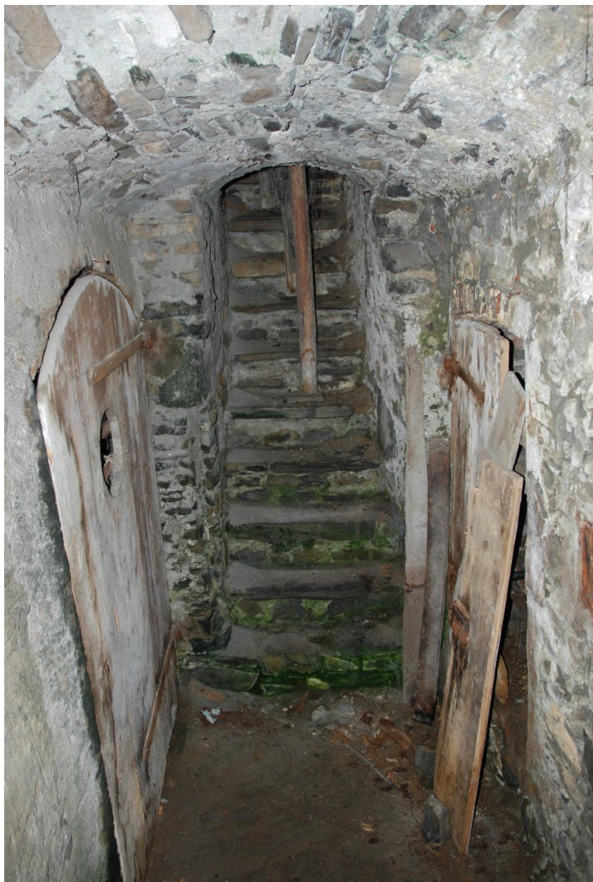
Maison de vigneron (2018 E3 760). Escalier et couloir d'accès aux caves.
