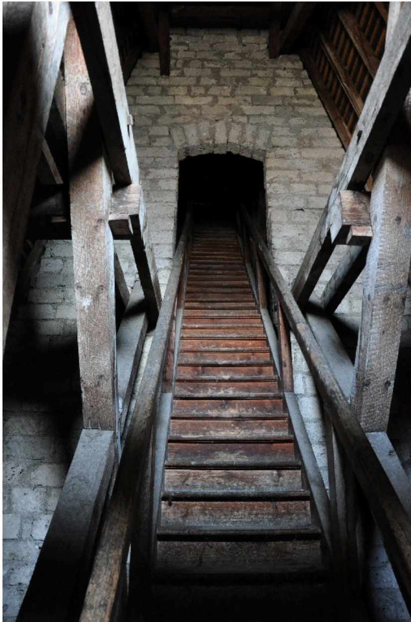
Accès au toit central depuis les combles
