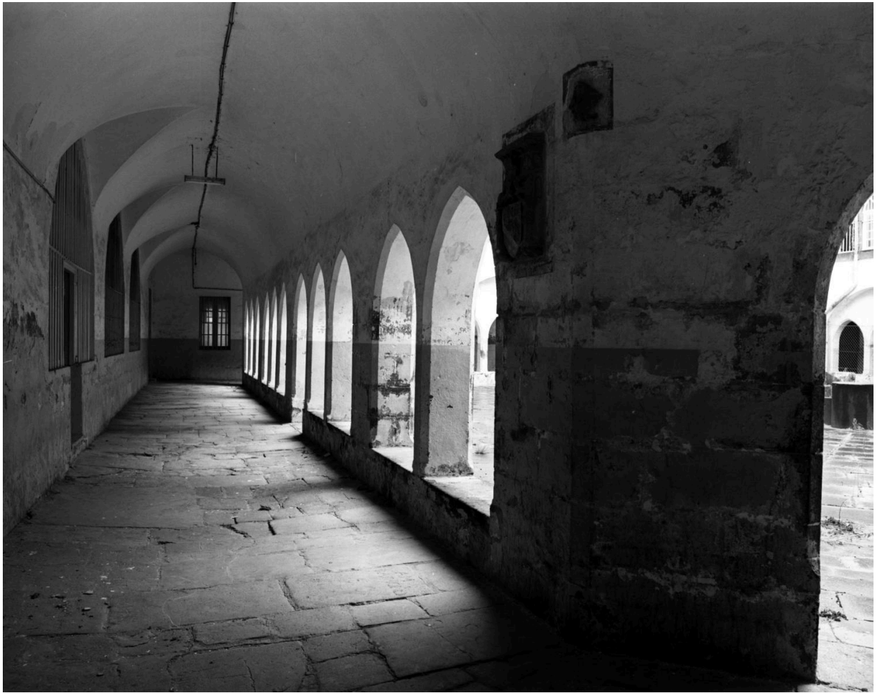
Cloître, vue générale de la galerie nord.
