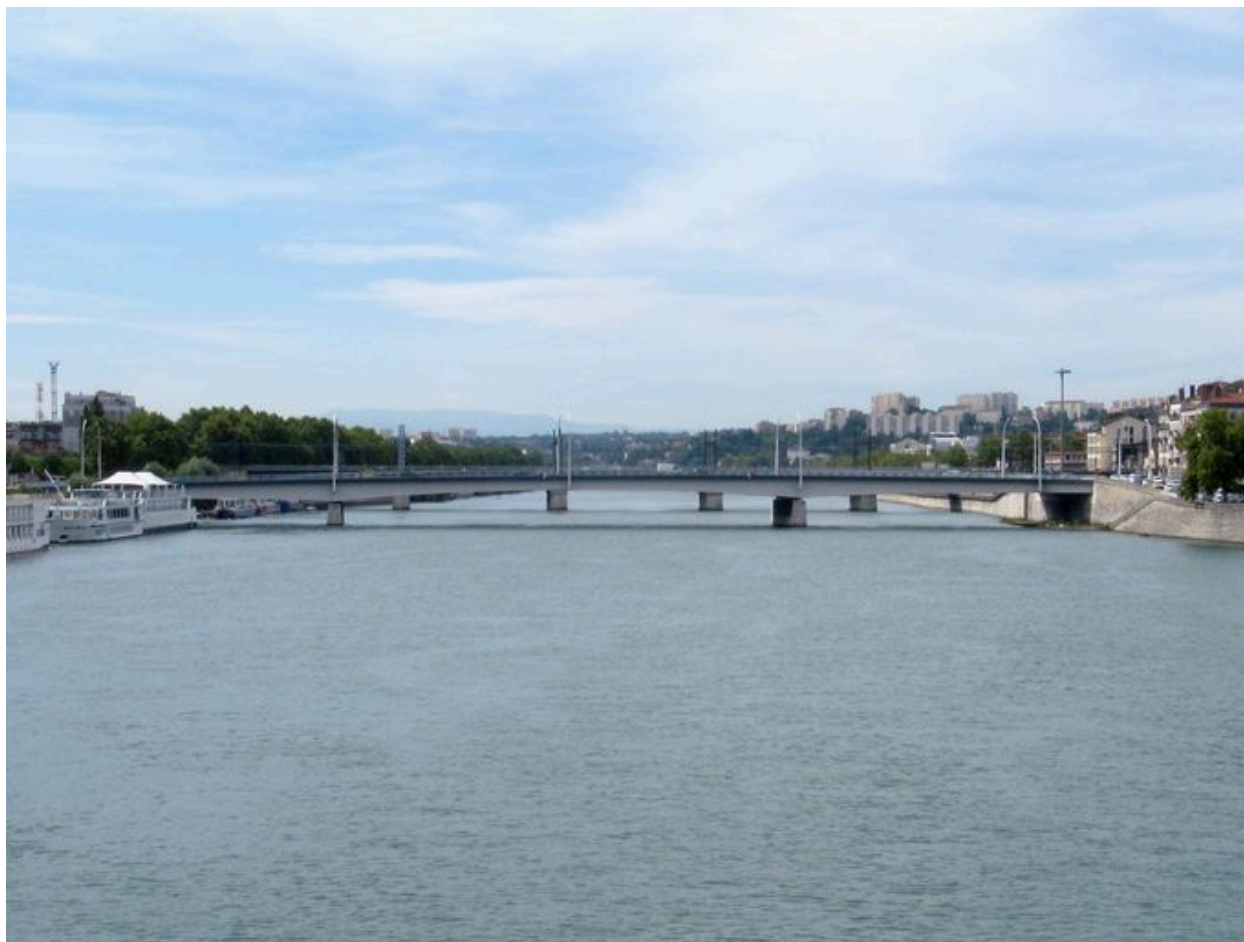
Vue générale, face amont (depuis le pont de l'Université)
