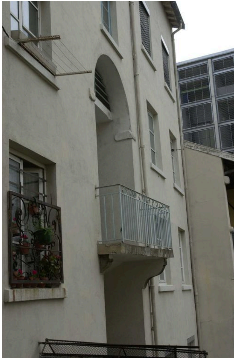
Elévation postérieure : un balcon de la montée d'escalier
