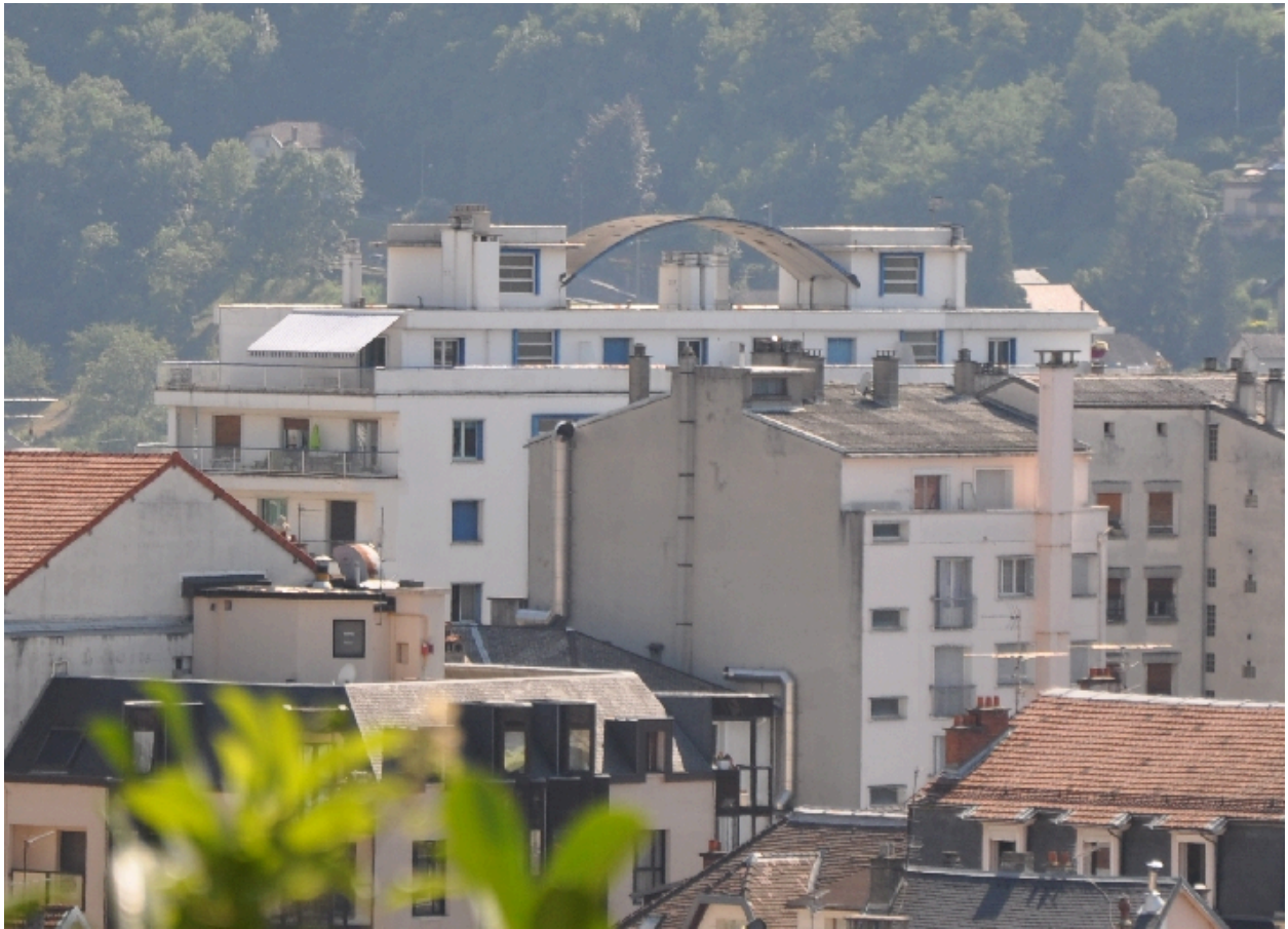
Voile de béton et lanterneaux de la toiture
