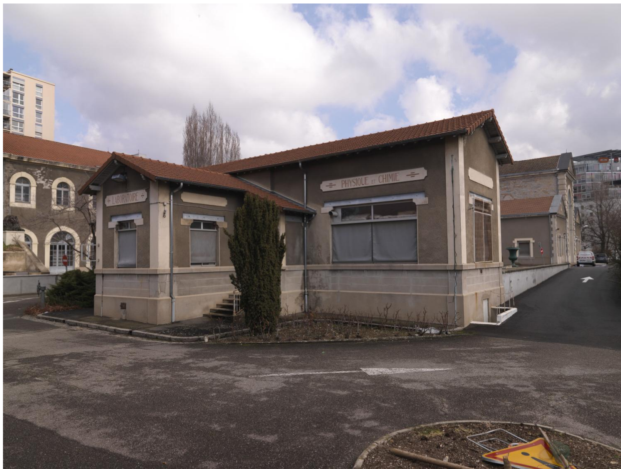
Vue des bâtiments : laboratoire physique et chimique
