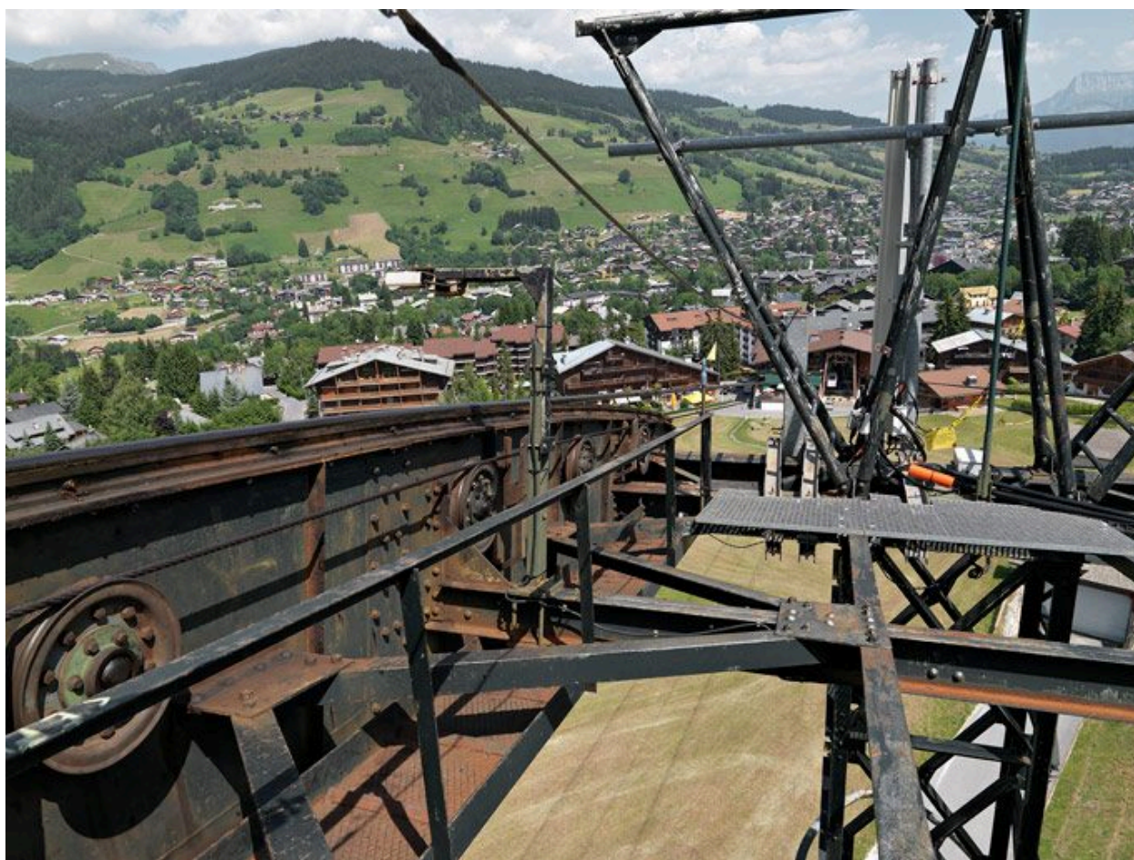
Détail du pylône de la gare inférieure
