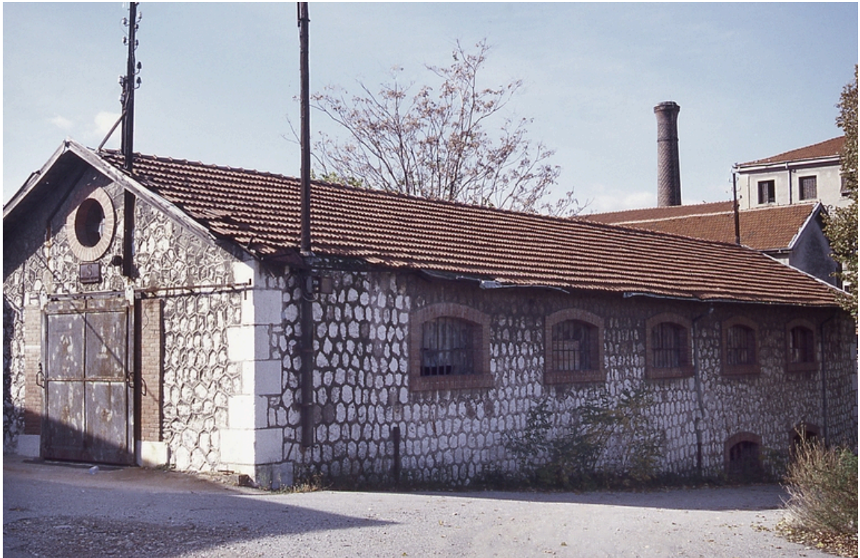
Annexe de la cartoucherie, démoli
