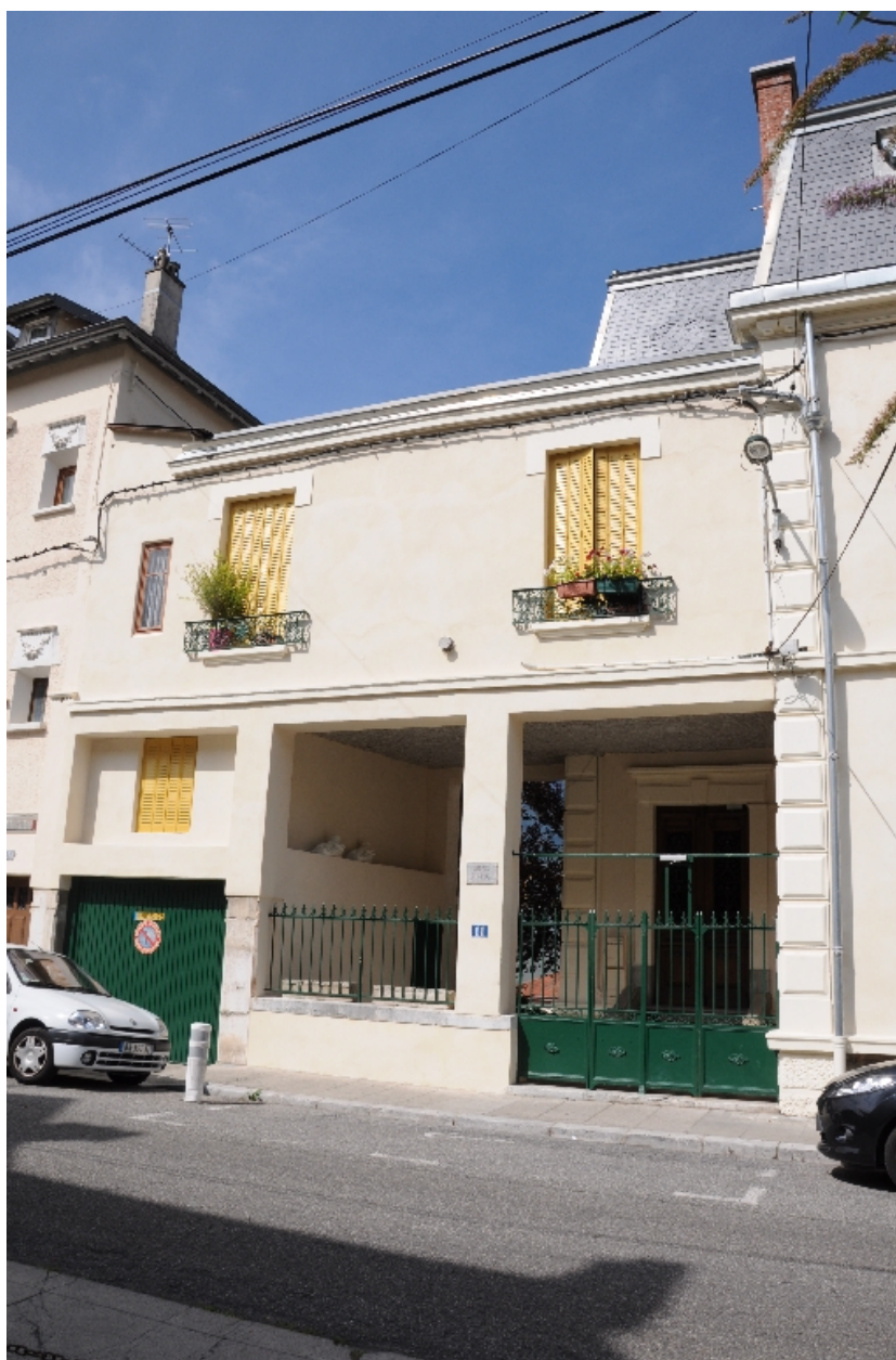
Agrandissement sur passage couvert
