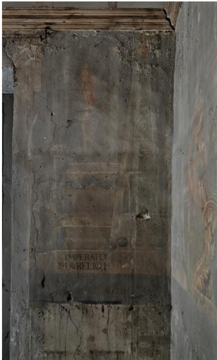
Mur sud, détail de la partie latérale droite, sept. 2018
