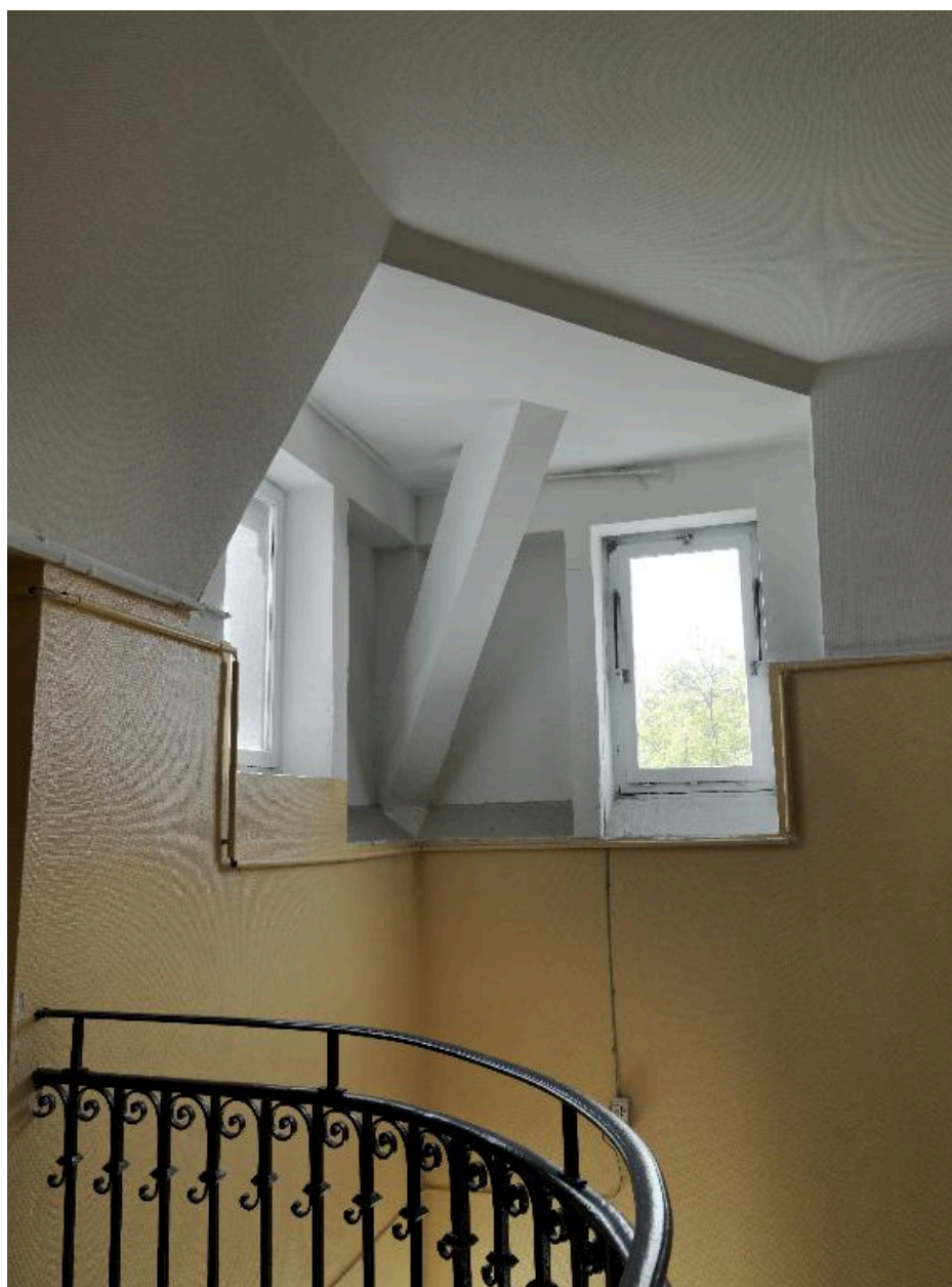
Escalier sud, détail des fenêtres éclairant la cage au dernier niveau
