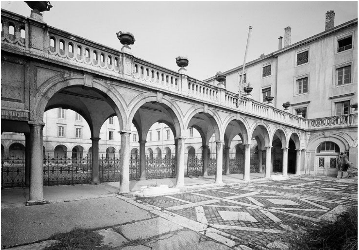
Corps de portique, côté cour
