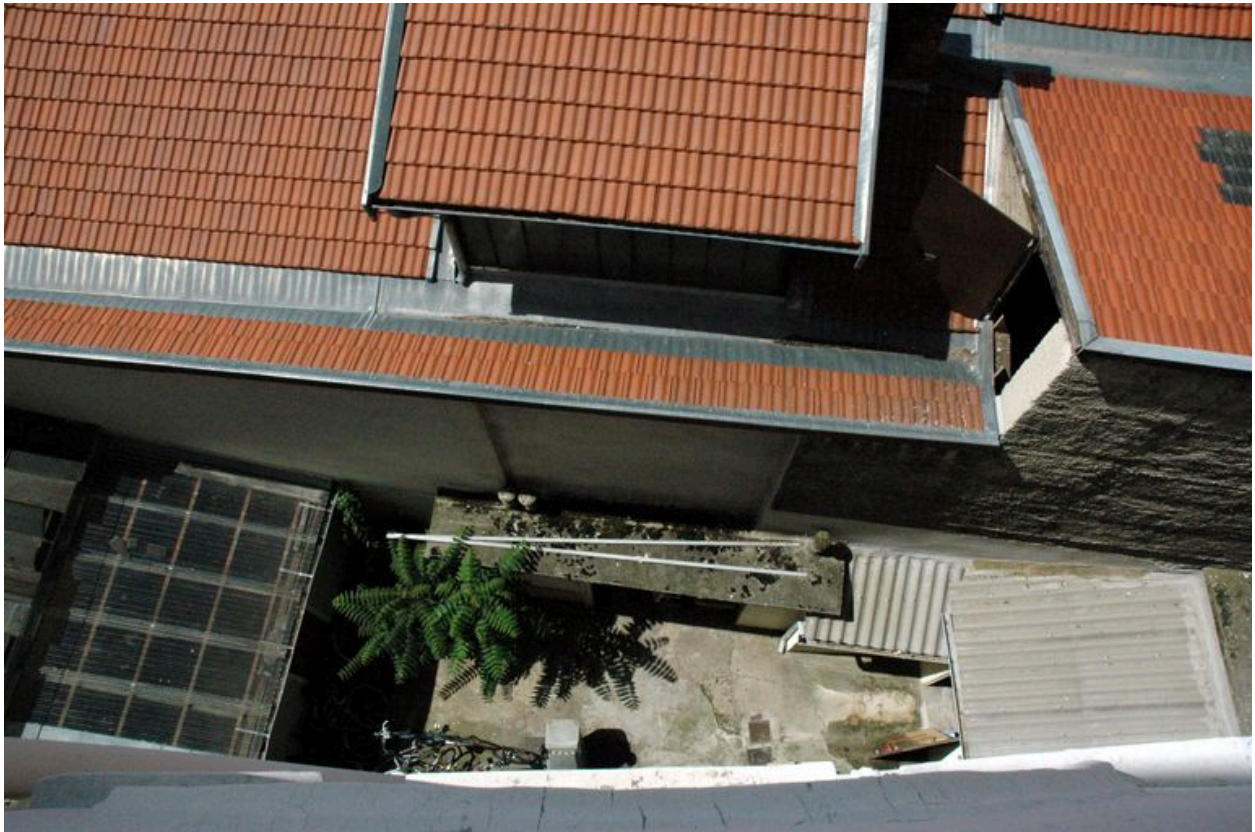
La cour depuis un étage
