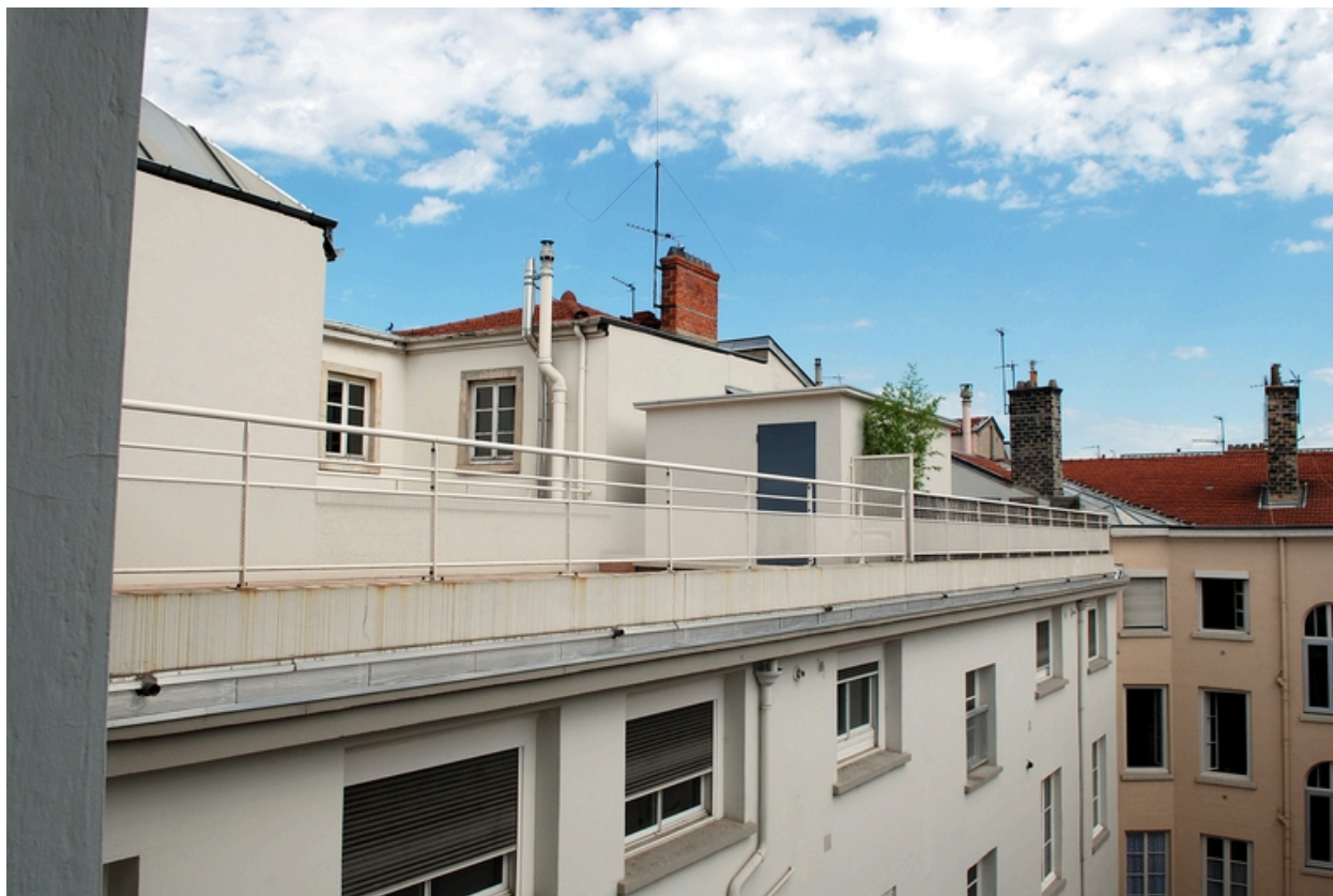
Elévation sur cour : terrasse du corps de bâtiment ouest
