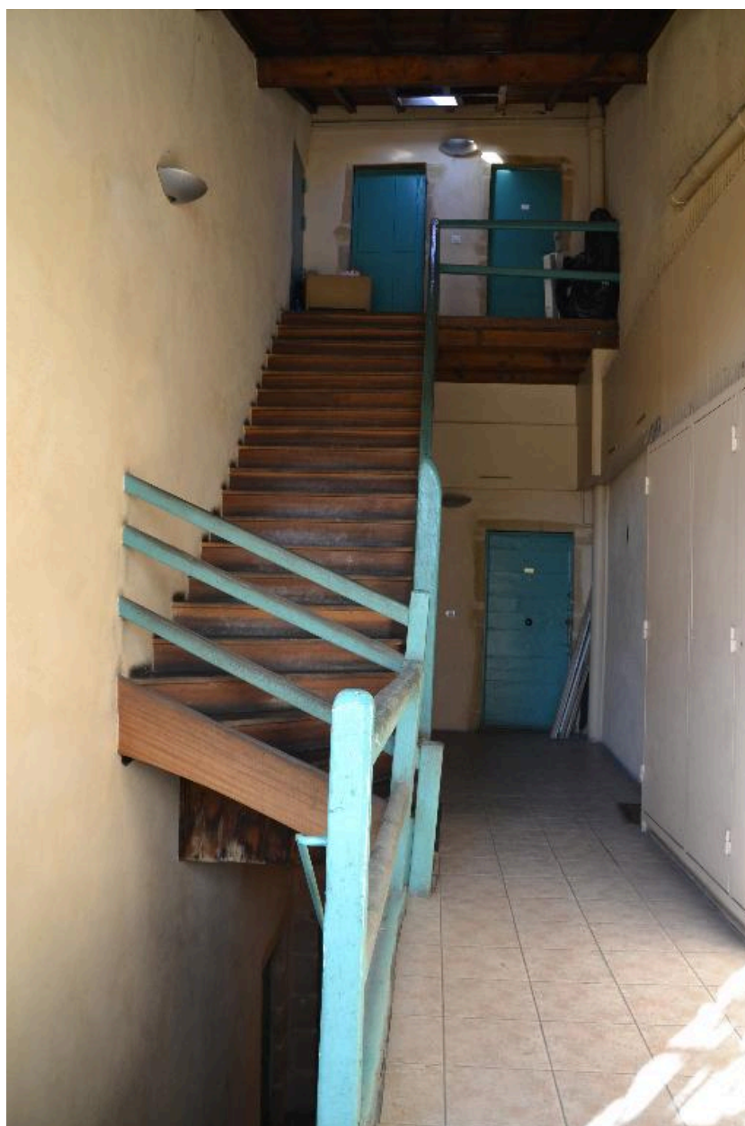
Escalier dernier niveau
