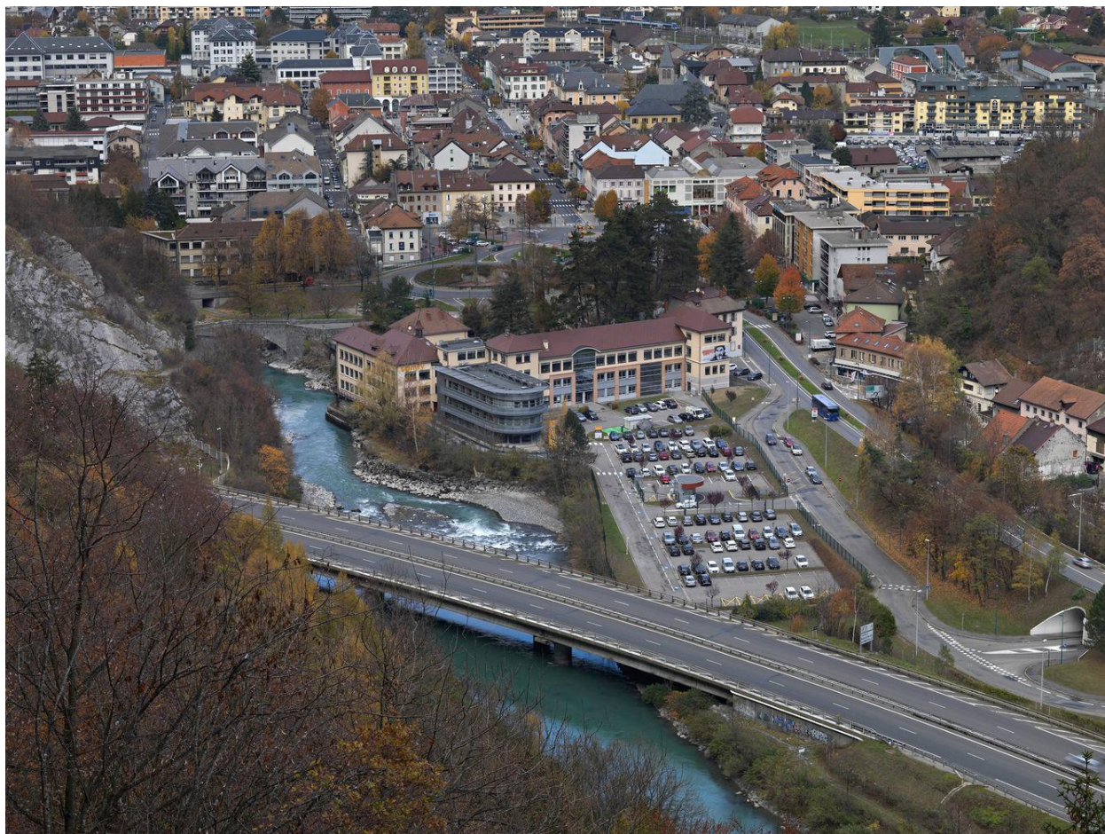
Vue d'ensemble sud-ouest
