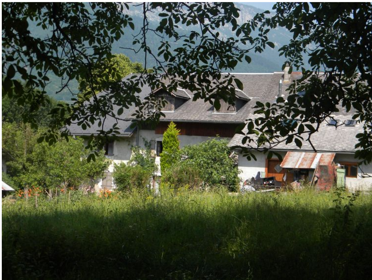
Vue de la façade arrière.
