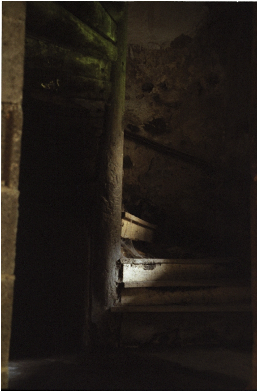
Vue d'ensemble intérieure de l'escalier en vis sans jour.
