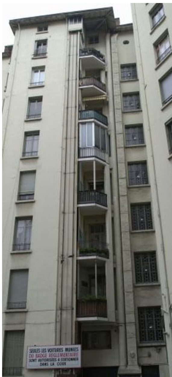
Détails de la façade postérieure : monte-charge, balcons et vitraux de la cage d'escalier
