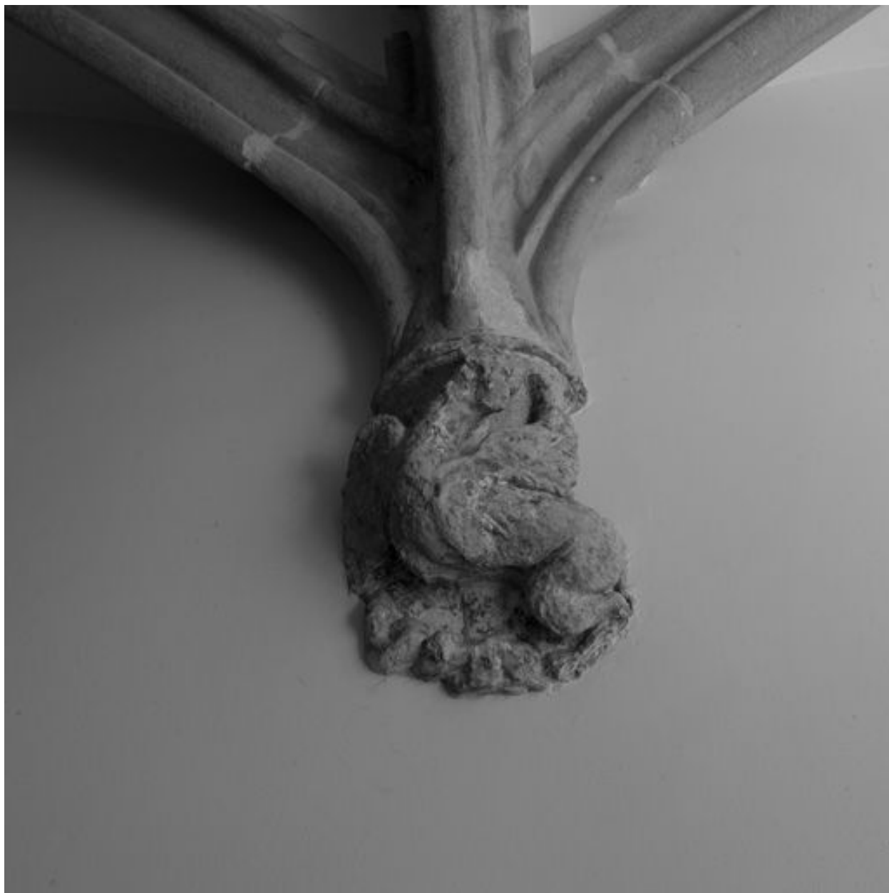
Voûte de l'allée, détail du culot 9
