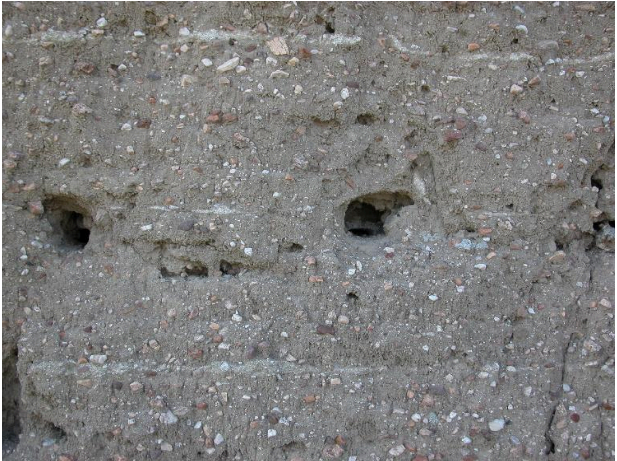
Détail du pisé mis en œuvre.
