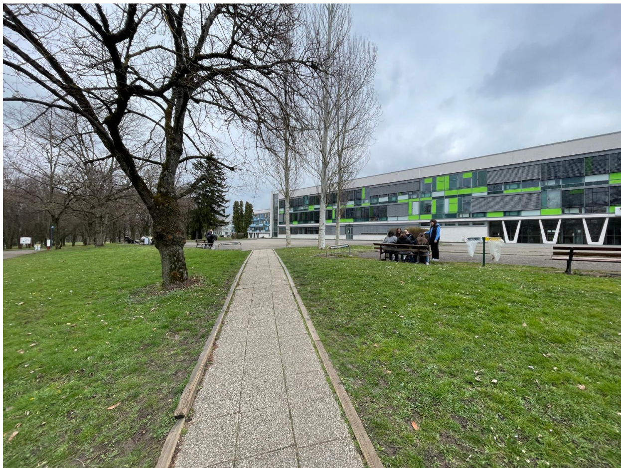
Bâtiment B, vue d'ensemble
