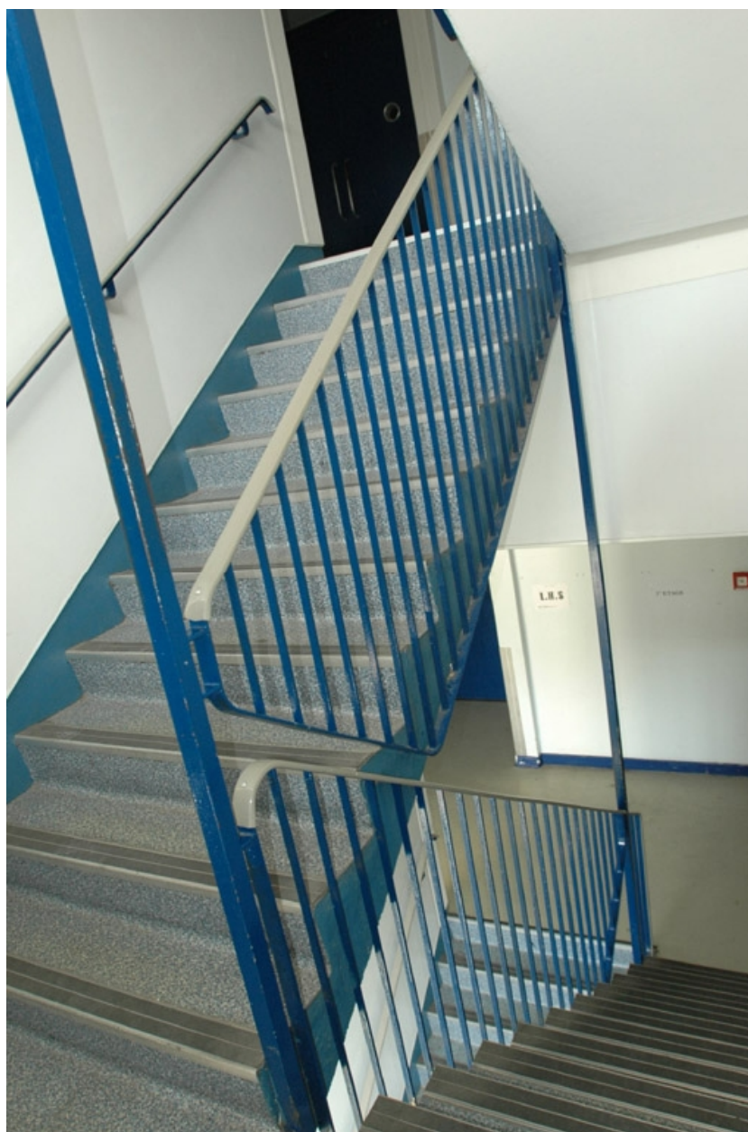
Escaliers de distribution des étages
