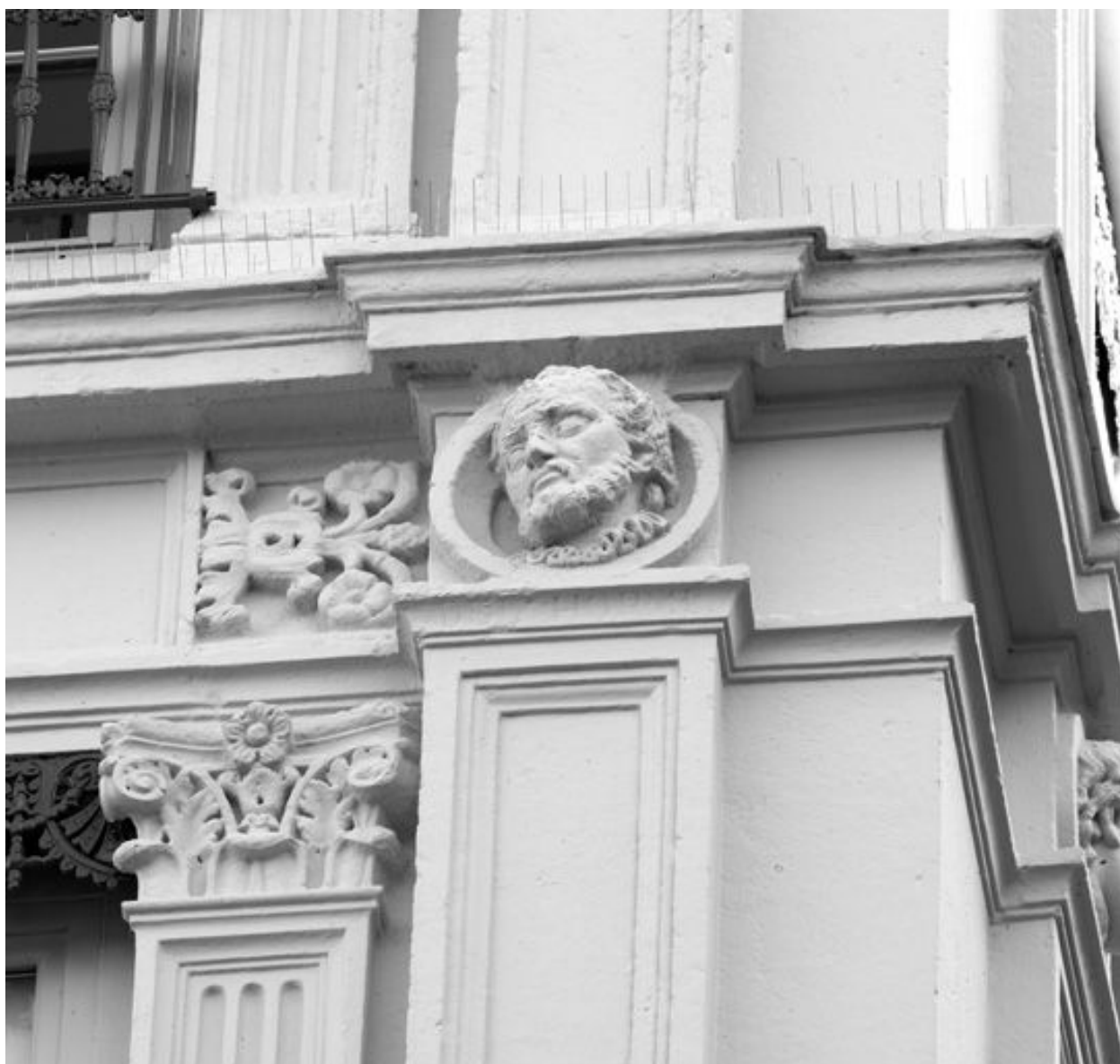
Façade place d'Albon, 5e niveau, détail du médaillon de droite représentant Philibert Delorme
