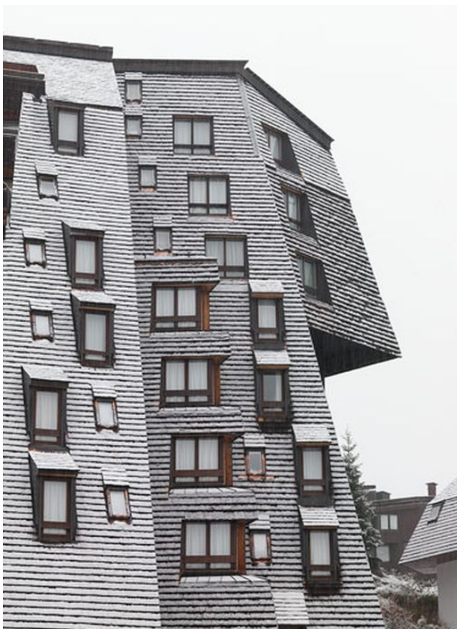
Façade sud. Détail
