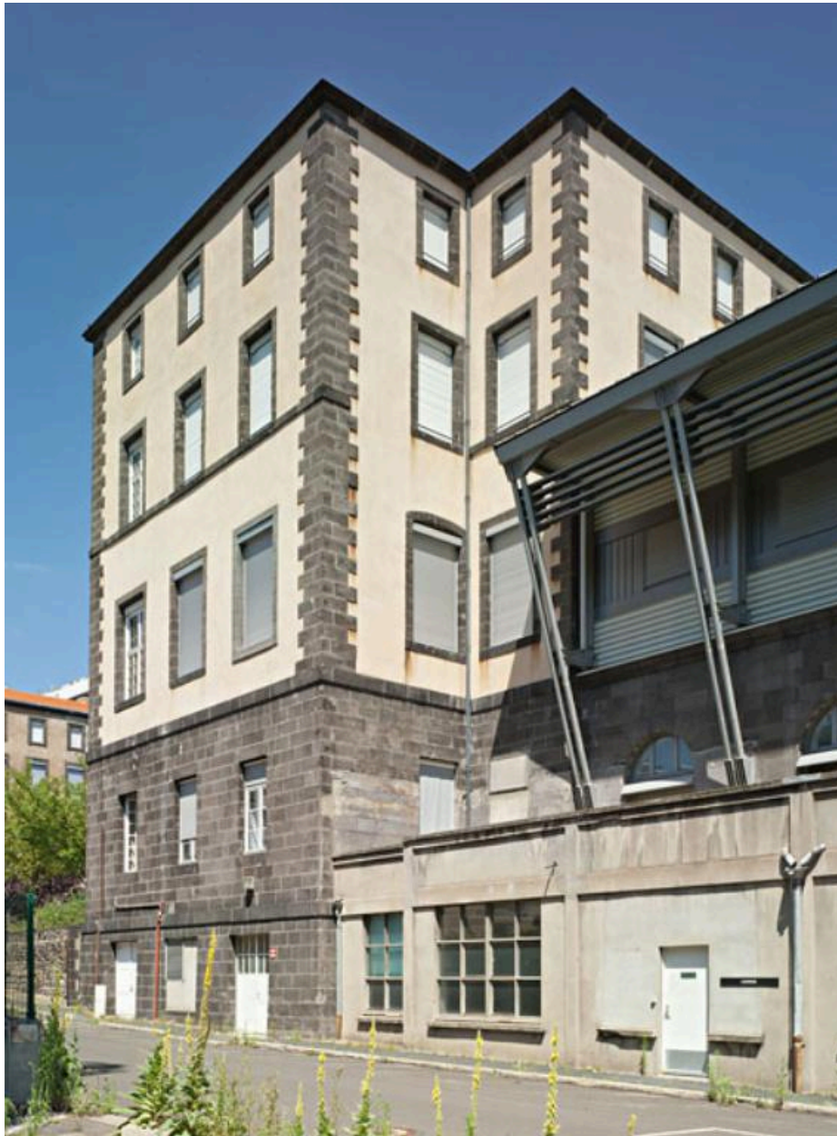
Hôtel-Dieu de Clermont-Ferrand. L'hôtel-Dieu, corps de bâtiment médian, façade ouest et angle sud-ouest.
