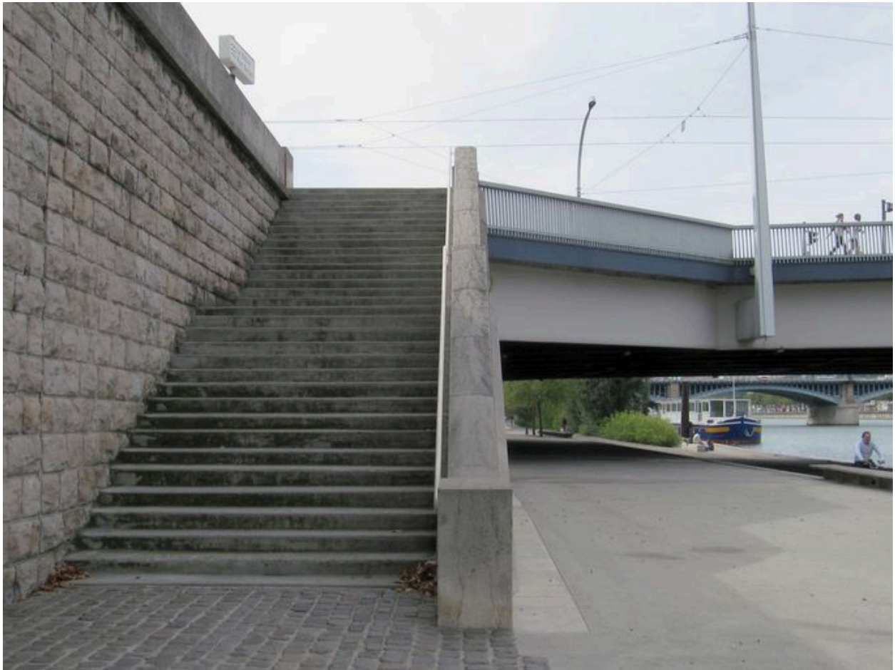
Travée gauche, face amont, vue partielle : escalier d'accès au quai (depuis la rive gauche)
