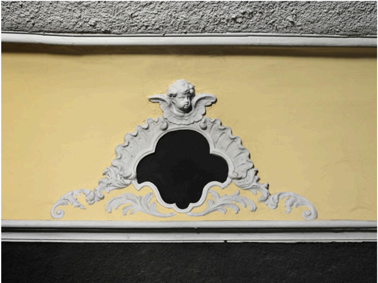
Corniche du plafond, détail : motif à angelot.
