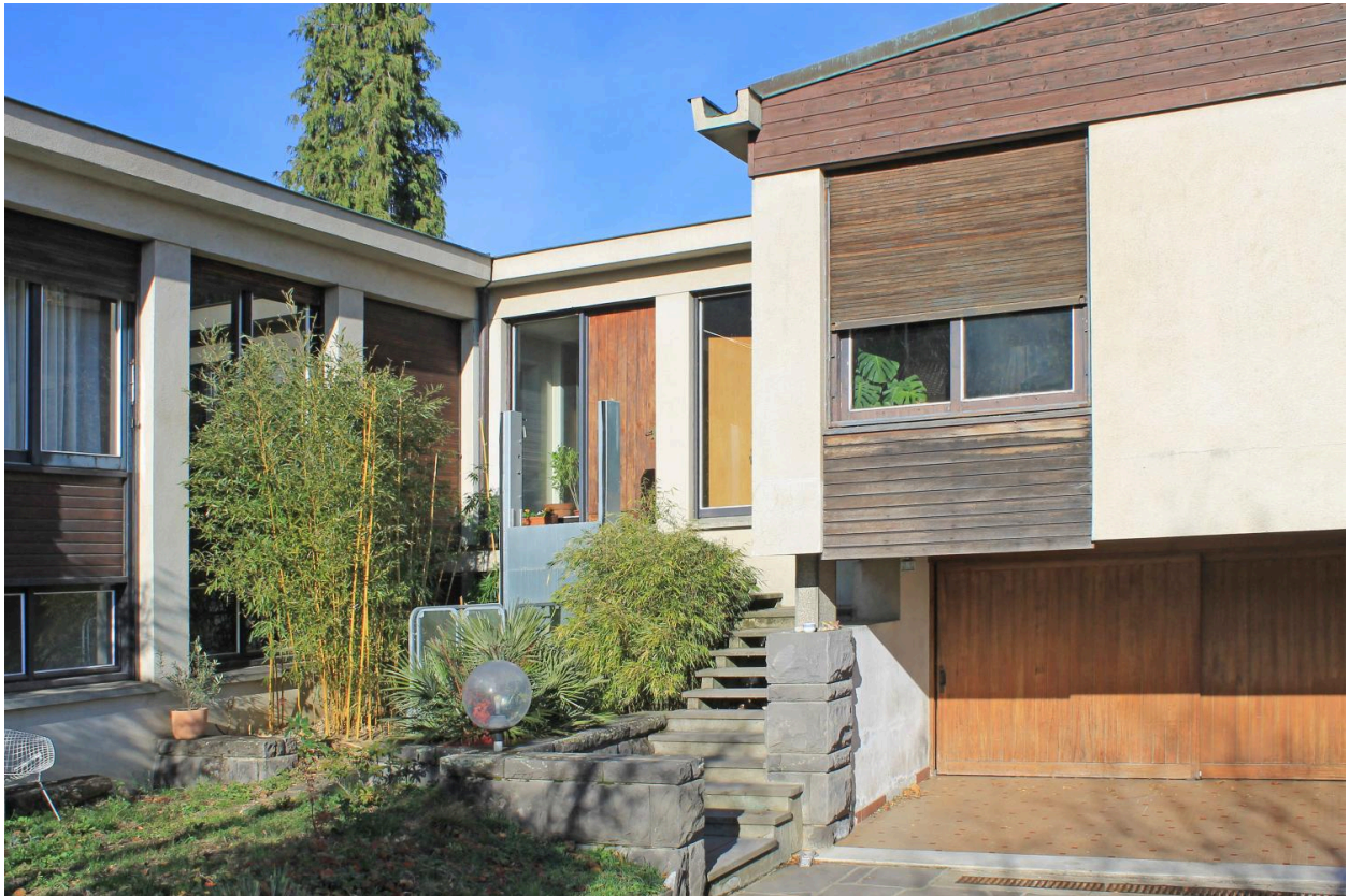
Ceyrat, la maison L., mise en scène de l'entrée principale.
