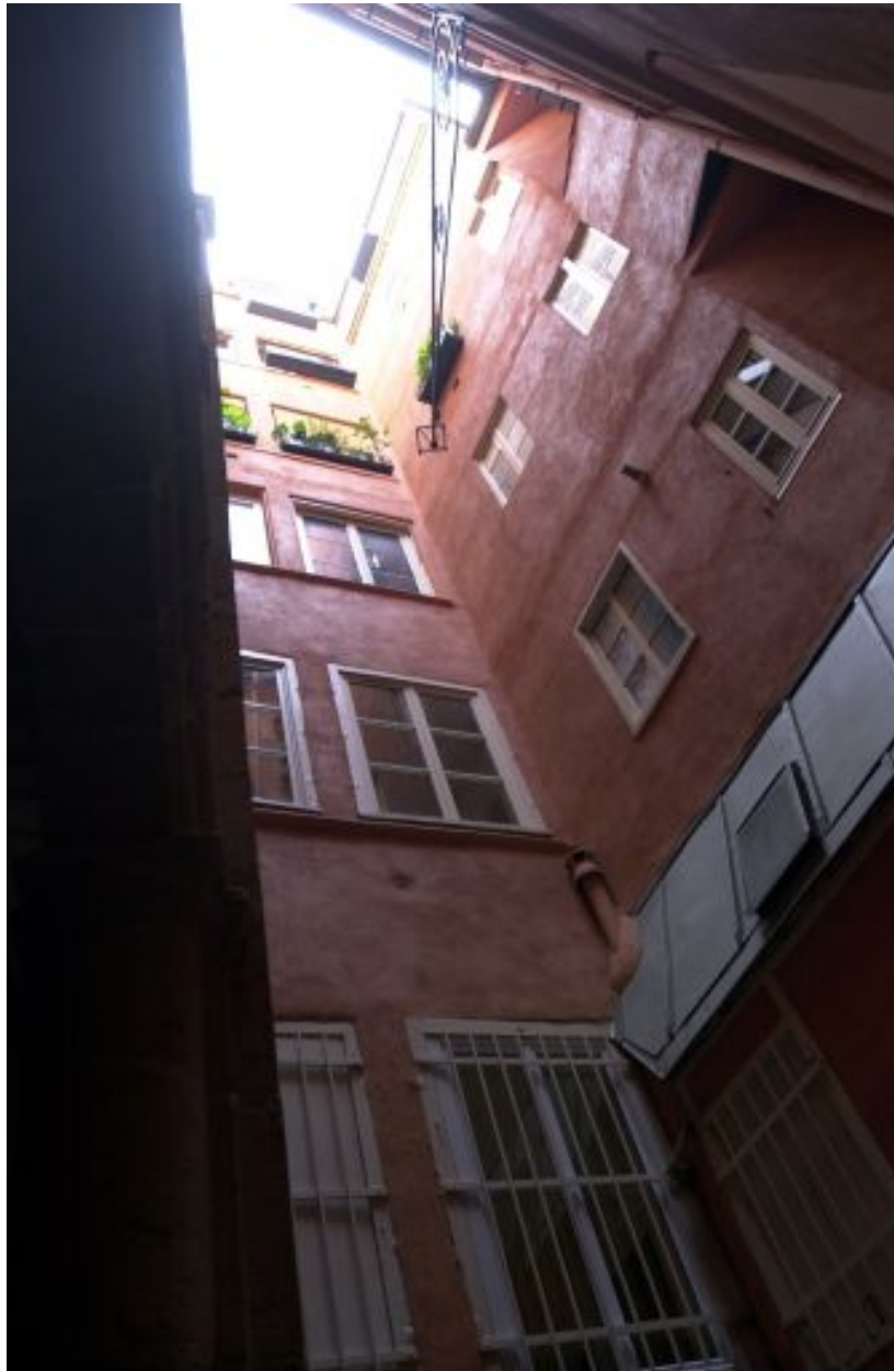
Cour I, élévation du bâtiment 1 et des galeries de liaison
