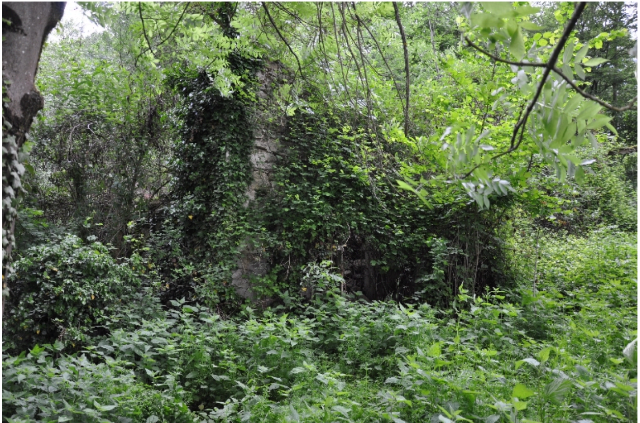
Vue de la façade ouest du moulin amont, ancien emplacement de la roue
