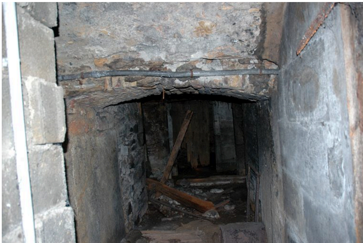
Couvent : 3 rue des Templiers, caves : arc de passage surbaissé
