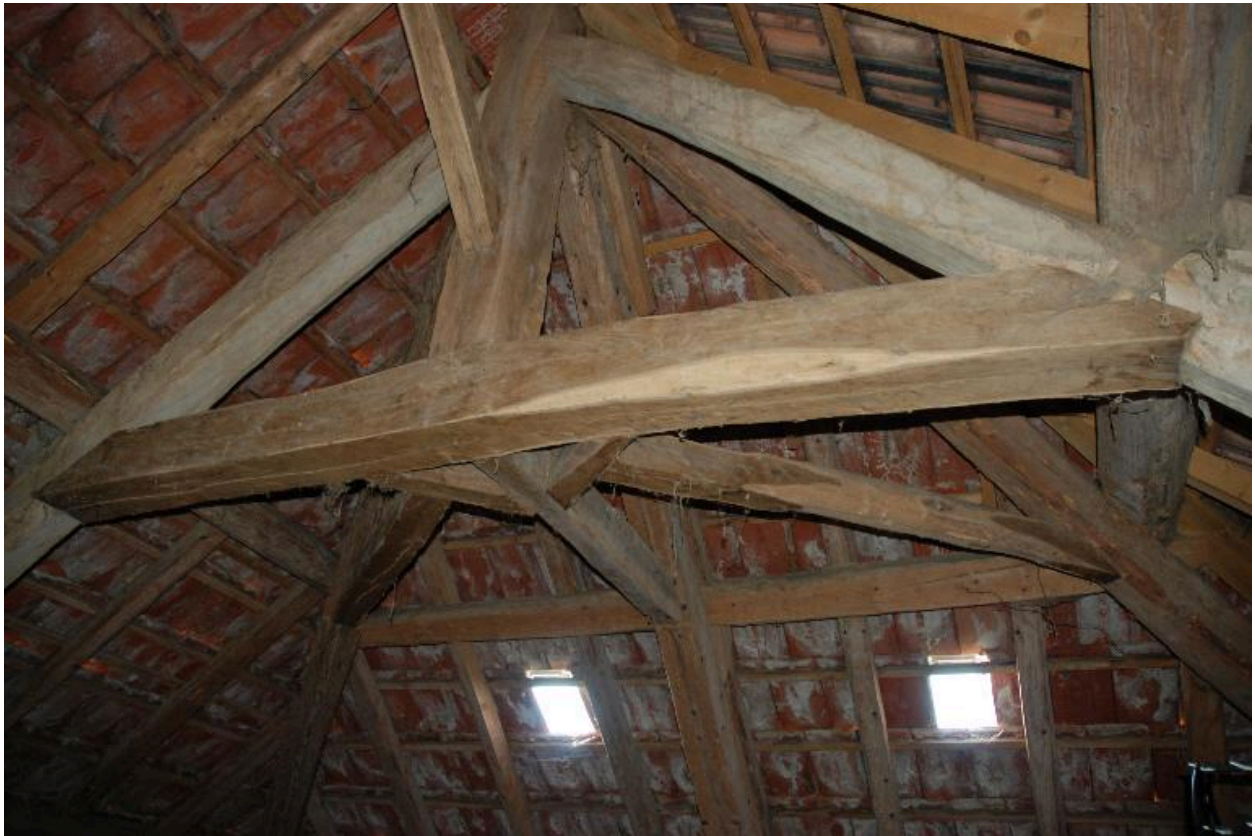
Vue intérieure du comble, charpente de la croupe.
