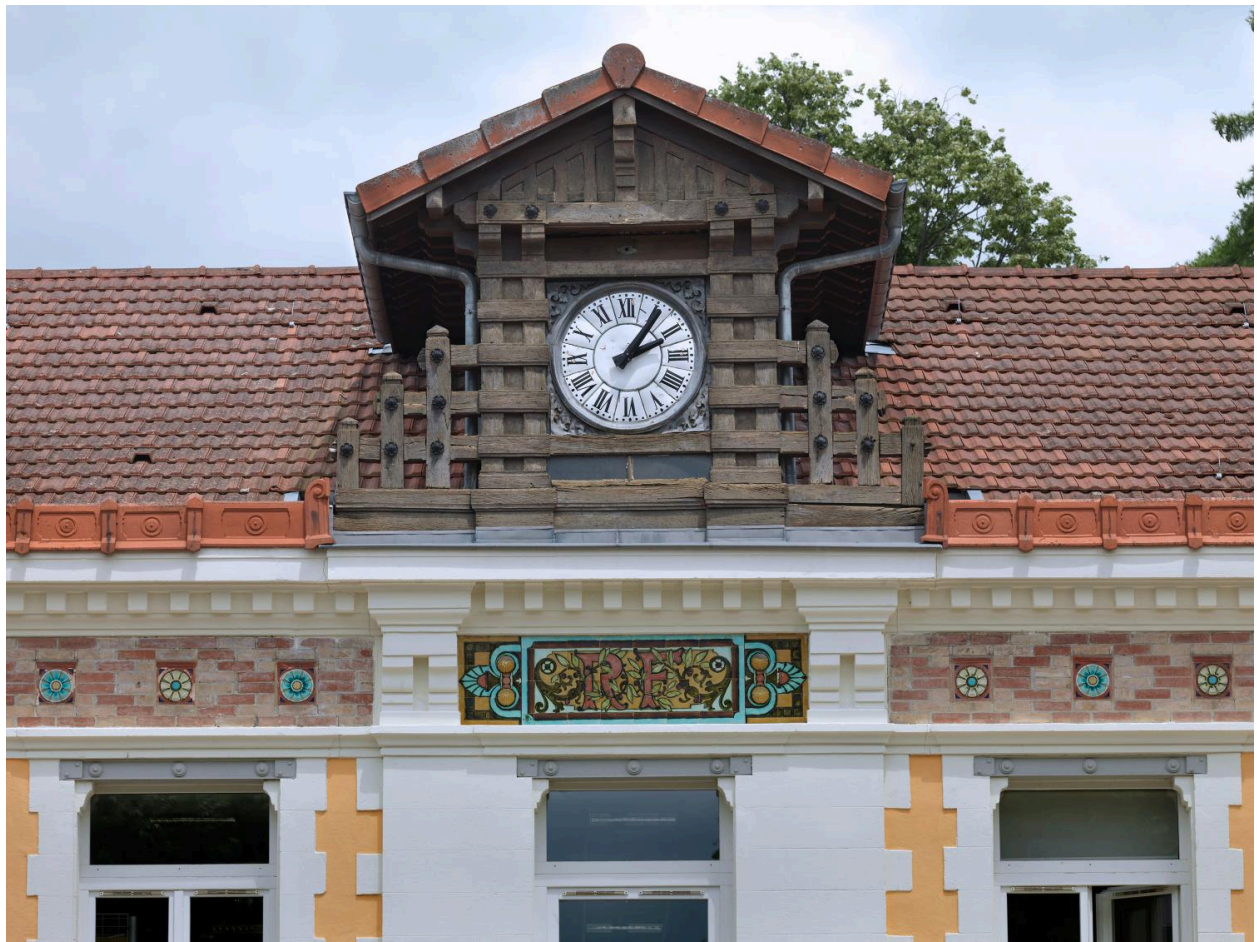
Bâtiment de l'administration : détail du décor, frise et horloge
