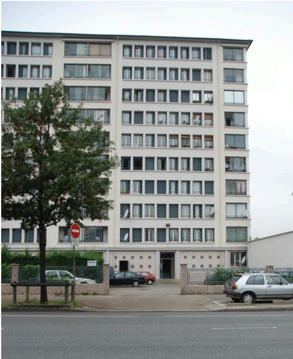
Vue d'une travée
