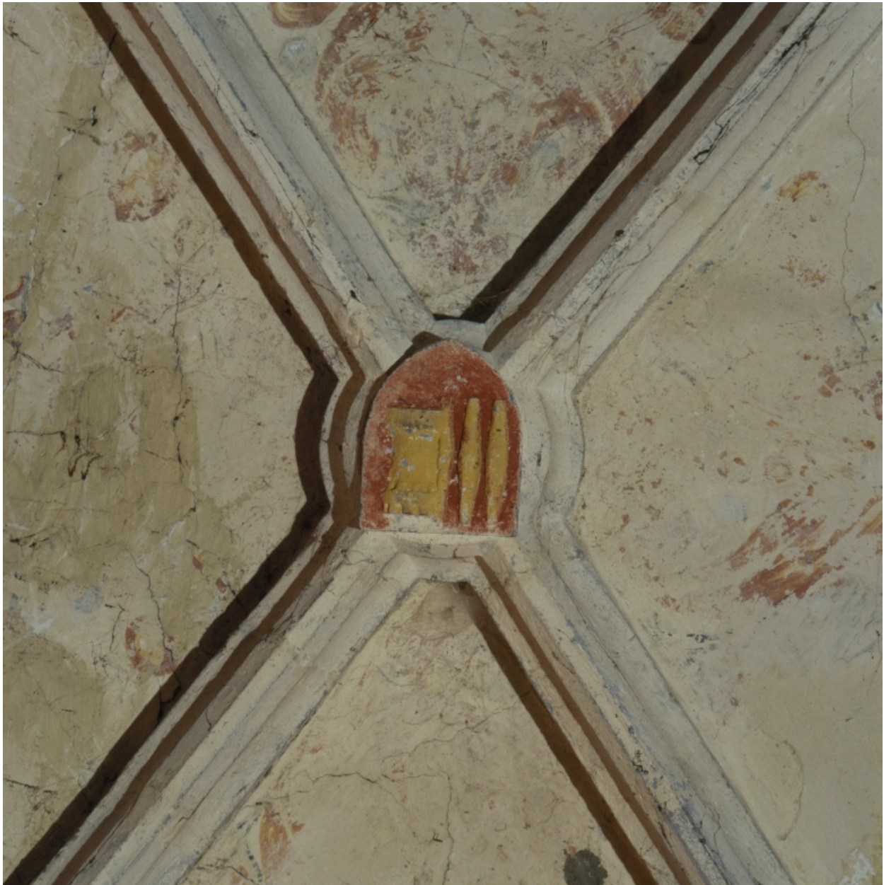
Clef de voûte aux armes des Saint-Nectaire, parti d'Alègre, première travée du bas-côté (d).
