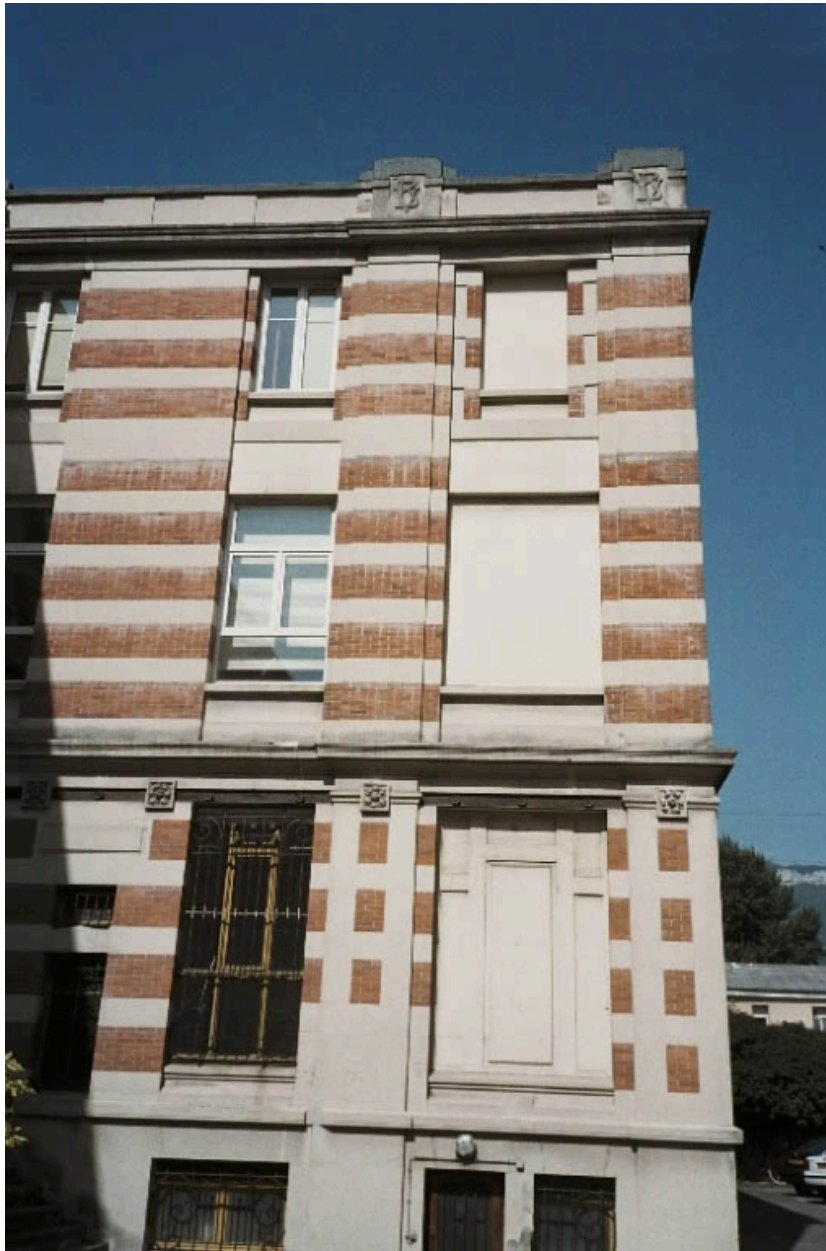
Vue extérieure du bâtiment
