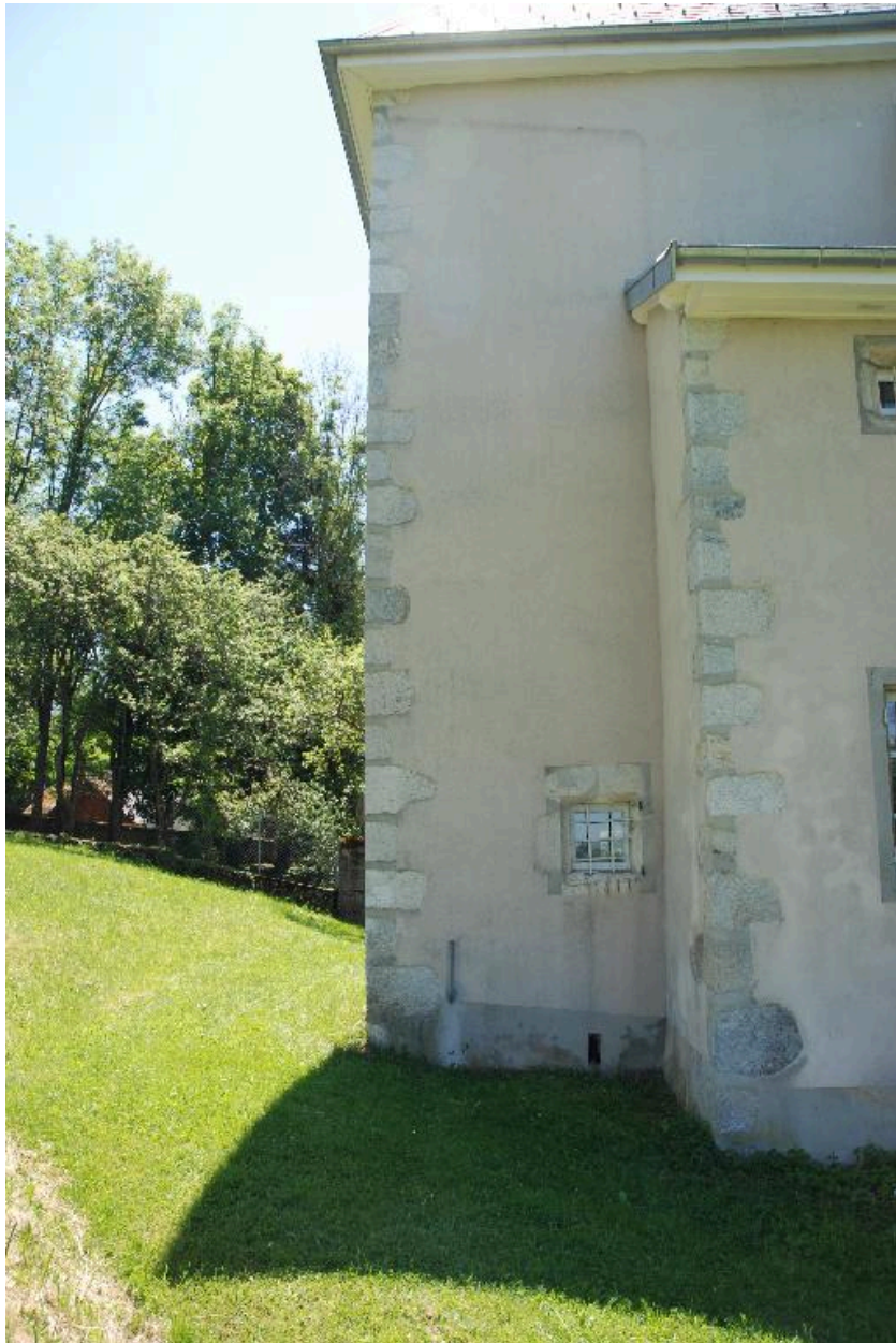
Angle de la tour sud-est du château.
