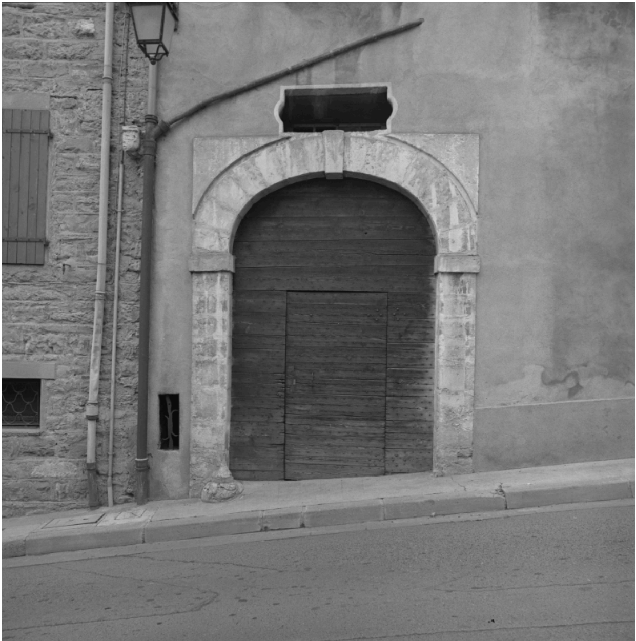
Portail sur rue de Gouvernement, de l'immeuble 3 Grande rue.
