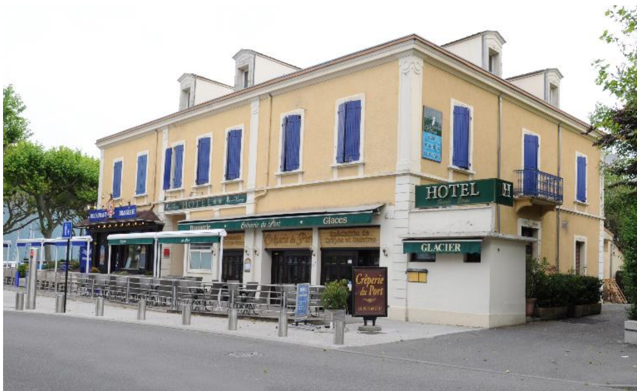
Terrasse devant la façade sud et façade est
