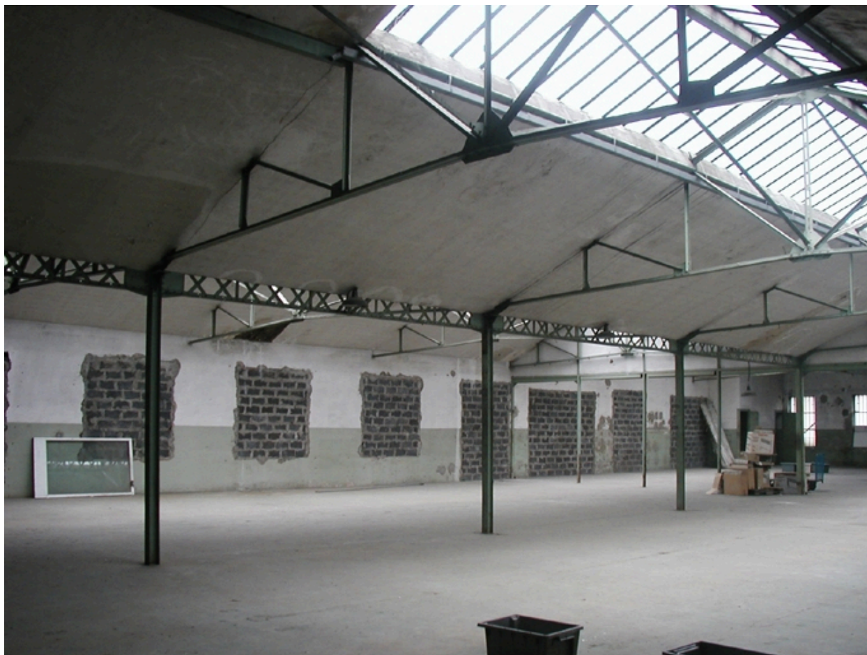
Vue d'ensemble du second niveau
