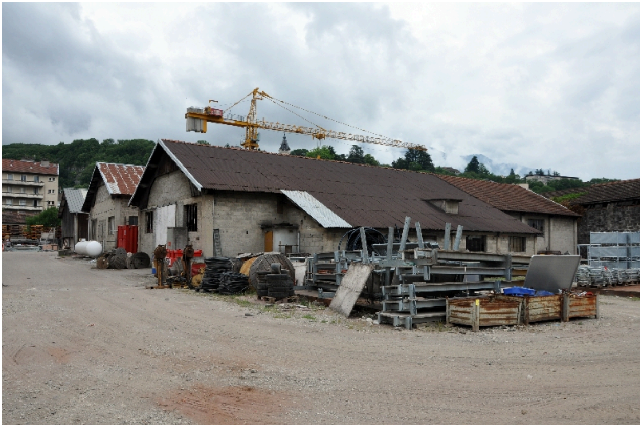
Entrepôts sud vus depuis l'ouest
