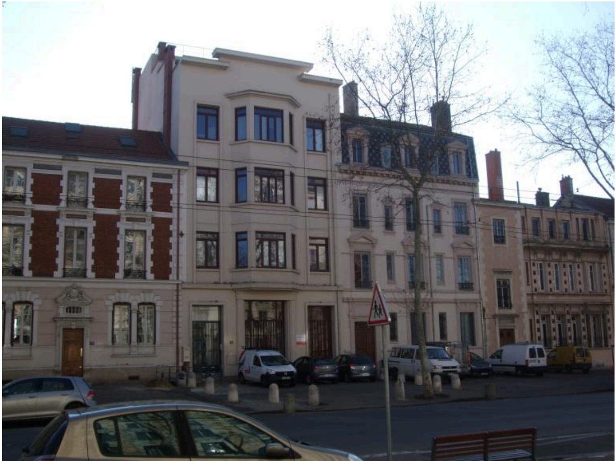
Vue d'ensemble nord de l'usine de ventilation 3
