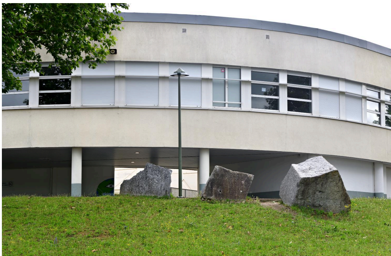
Vue des trois blocs
